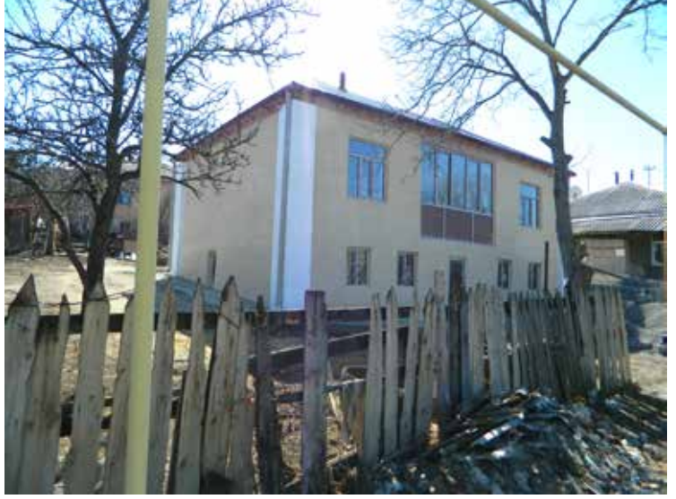
Yeniden yapılan ev.
